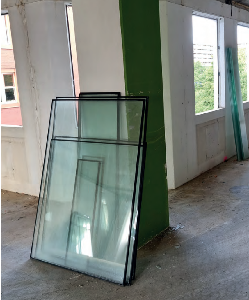
Gedemonteerde be- glazing op weg naar hergebruik (foto: Steven Koolman).
